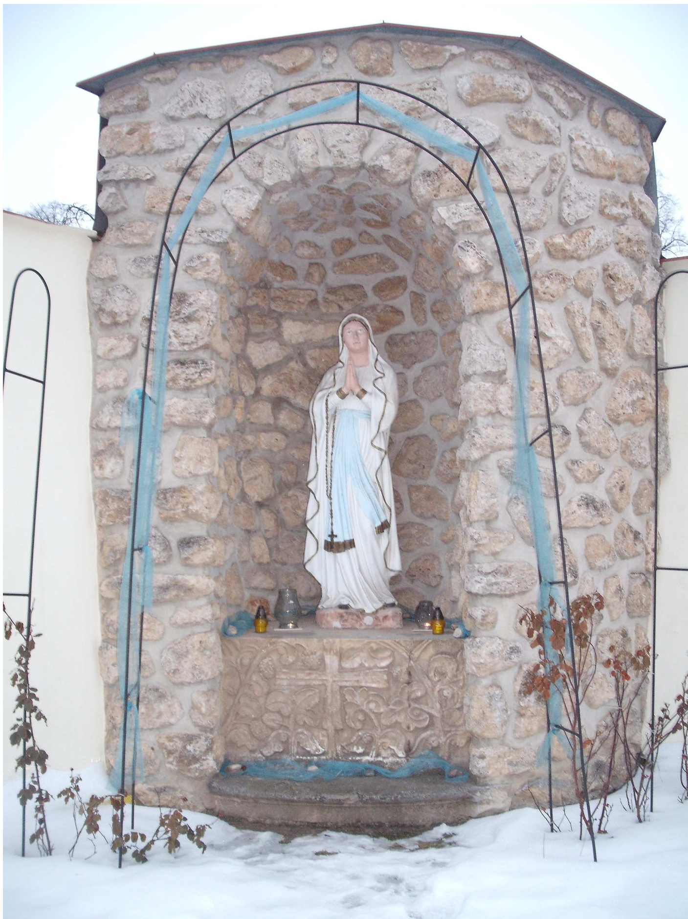
Foto sochy před opravou – leden 2017
